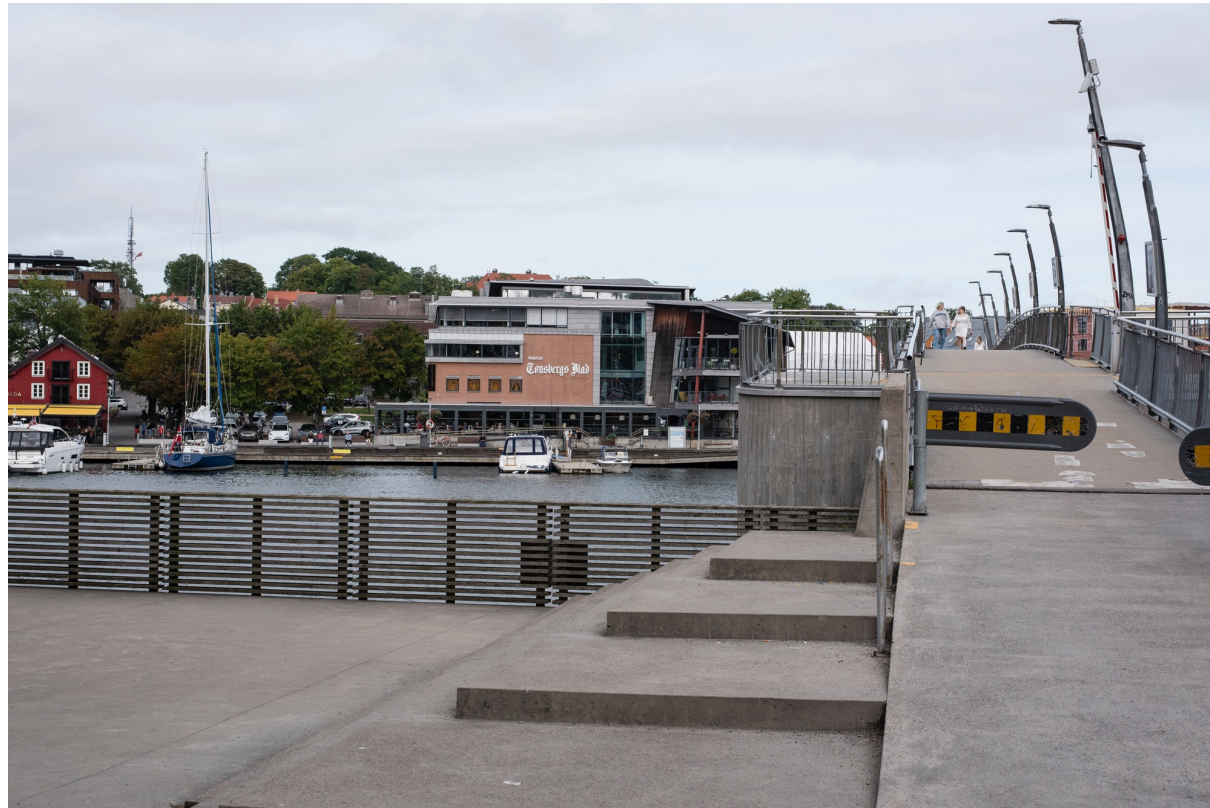
Fra gangbruen: FØR
